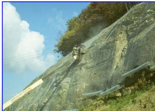
**Foto 1** – Anbringung eines Steinschlagschutzzeugs in der Felswand, Verbindung der Netzbahnen mit doppelter Torsion
