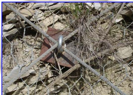
**Foto 4** – Detail des Ankerkopfs, der Platte und der Ringmutter
