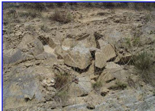
**Foto 3** – Das Foto zeigt das Rückhaltevermögen des Netzes und des Seilgitters für abgelöste Blöcke
