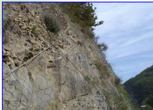
**Foto 2** – Detail eines Eingriffs in der Wand mit Steinschlagschutznetz, Nägel und Anker mit Stahlseile aus Litzen
